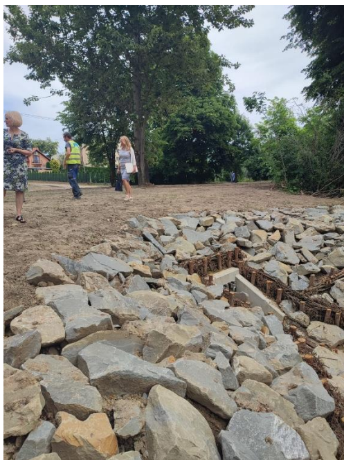
Fot. 1 źródło własne – wylot kanalizacji deszczowej do potoku Błonie
